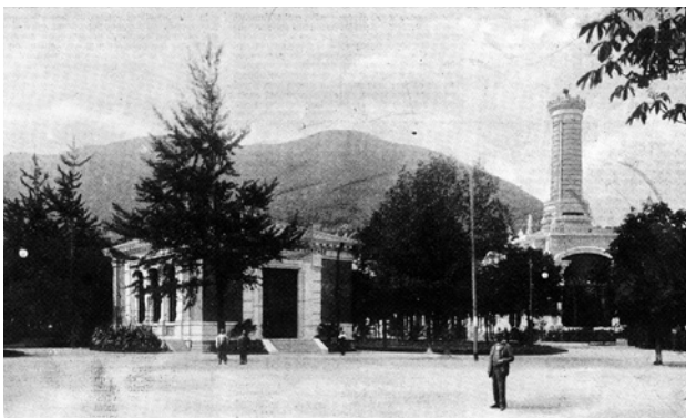
Figura 10. La torre in forma di pila che ospitava l'ascensore Stigler (Como 1899)
