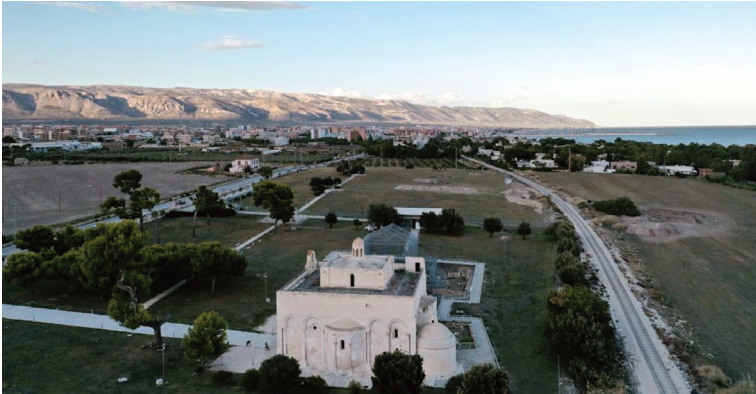
Figura 16 Veduta aerea dell'area archeologica di Siponto: in primo piano la chiesa medievale di Santa Maria di Siponto. Si notino a destra la ferrovia e a sinistra la strada che tagliano in tre parti il sito archeologico (© Maria Potenza)
