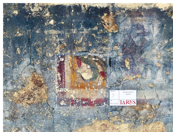
Figura 6 Prova di pulitura dei dipinti murali del prospetto sud. © Lares
