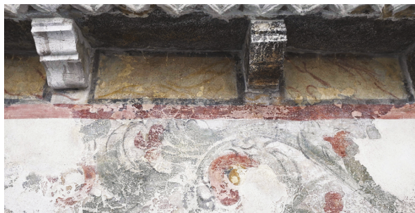
Figura 7 Dettaglio del finto mattonato rosso a losanghe dopo l'intervento di restauro. © Lares
