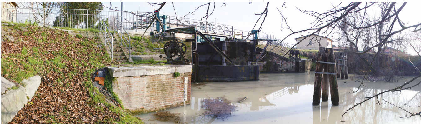
Figura 1 San Donà di Piave, Musile di Piave, Chiusa Intestadura (2023). Vista del meccanismo, in primo piano uno degli argani vecchi
