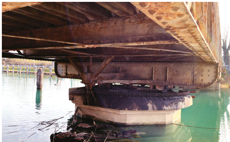
Figura 2 Venezia. Il ponte ferroviario-portuale a rulli, sul canale della Scomenzera (circa 1880?). © Irina Baldescu, 2022
