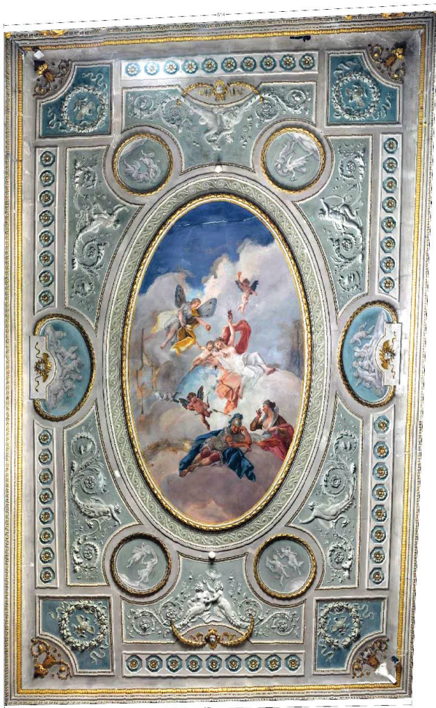
Figura 3 Soffitto del Salotto Verde prima dei lavori
