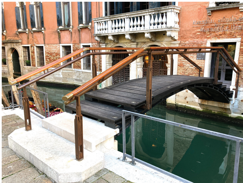
Figura 12 Dettaglio della campionatura per il trattamento sulle parti lignee e metalliche del corrimano
