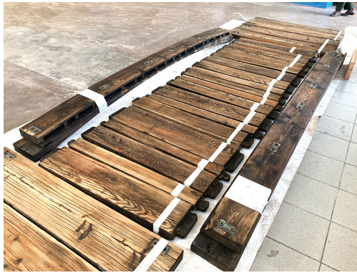
Figura 10 Smontaggio delle parti lignee del ponte Scarpa presso il laboratorio
