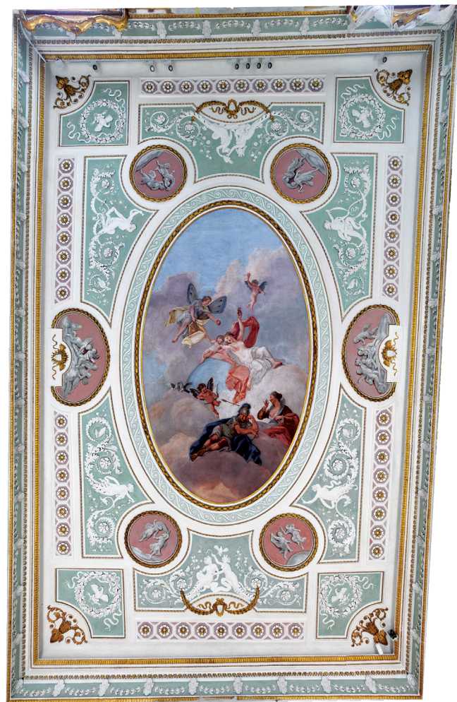
Figura 4 Soffitto del Salotto Verde a lavori ultimati, 2022
