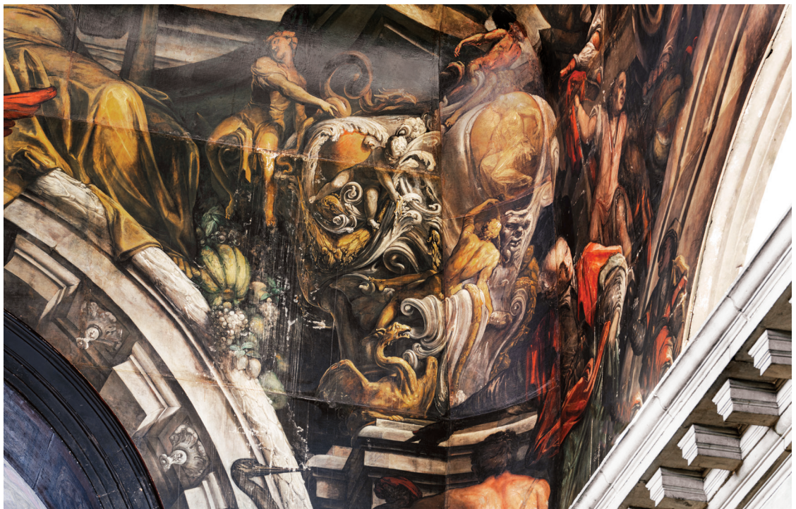
Figura 25 Particolare degli sbiancamenti presenti in corrispondenza dell'angolo sud-ovest del soffitto. © UNISVE 2024
