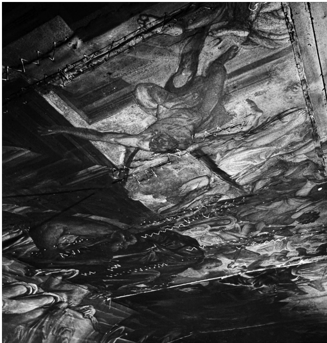
Figura 3 Particolare del soffitto prima dell'intervento del 1970 in cui sono visibili le cuciture in filo metallico, le chiodature e le patere. 1970. © Archivio fotografico G.A.V.E – su concessione del Ministero della Cultura – Gallerie dell'Accademia di Venezia
