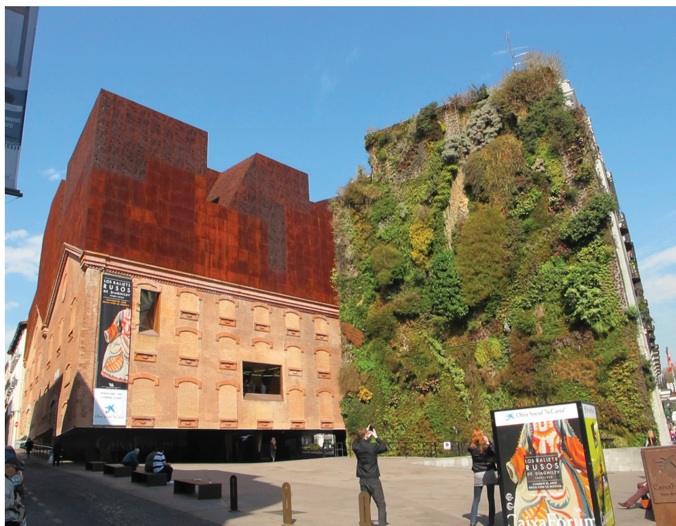
Figura 1 La vegetazione può ricoprire gli edifici grazie alla presenza di piante rampicanti con apparato radicale posto alla base, secondo un sistema che possiamo definire low-tech, oppure può rivestire le superfici ponendosi direttamente su queste, con piante di vari tipi, il cui apparato radicale è collocato sulle superfici stesse, con un sistema high-tech
