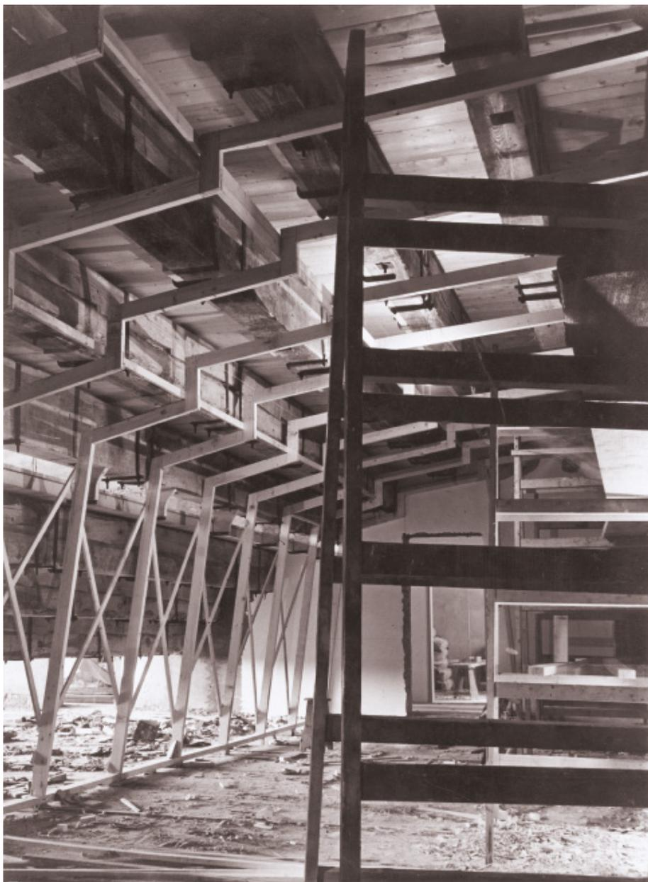
**Figura 95** Ca' Foscari, secondo piano, l'aula magna durante i lavori, foto di anonimo, [1936] (ASCF, Rettorato, Fotografie, 1149). La fotografia inquadra da sotto la gradinata in corso di costruzione.
