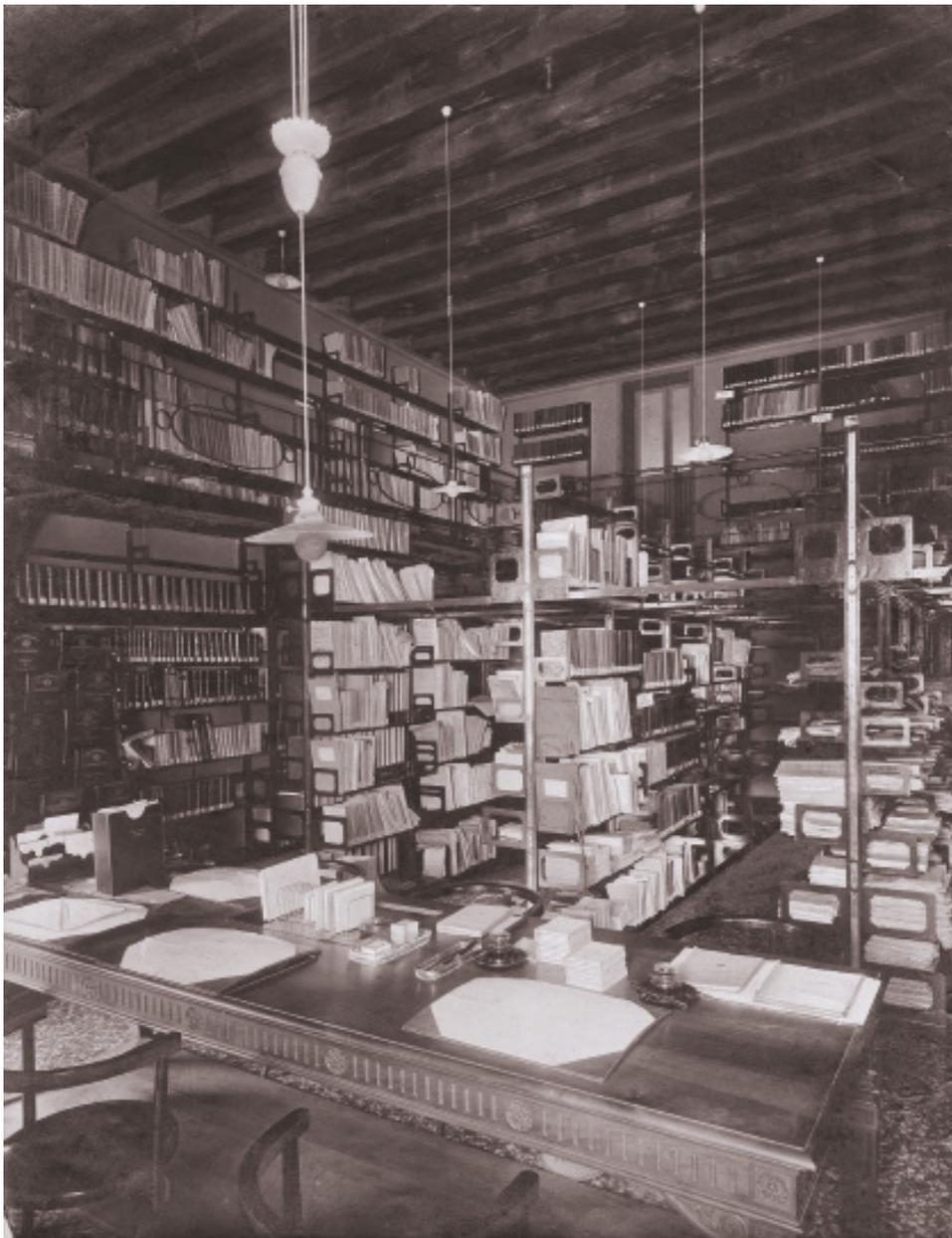
**Figura 93** Ca' Foscari, primo piano, Biblioteca, ufficio e deposito, foto Tomaso Filippi, [1915] (ASCF, Rettorato, Fotografie, 95): si riconoscono le scaffalature metalliche del sistema Lipman acquistate nel 1913 per sostituire i vecchi scaffali in legno in occasione del trasferimento della Biblioteca nelle nuove sale del primo piano.
