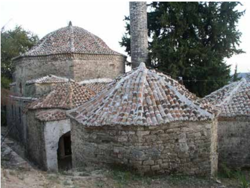
Figura 5. Rusanj, Albania. Il complesso della moschea nel 2007. Sono evidenti gli interventi di 'cementificazione' eseguiti nel tentativo di eliminare il problema dell'umidità
