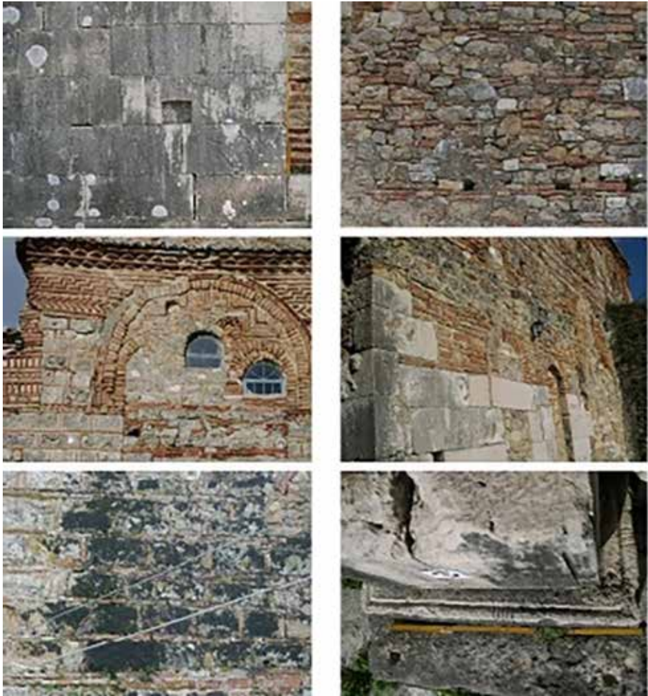
Figure 5a-f. Chiesa di San Nicola. Caratteri tipologici delle murature. Mesopotam, Albania (fonte: Brumana et al. 2012). 5a. Tipo A: grossi blocchi lapidei (37 × 50 cm) apparecchiati a filari regolari; 5b. Tipo B: mattoni di differenti dimensioni disposti con un cospicuo uso di malta; 5c. Tipo C: muratura cosiddetta 'a gabbia'; 5d. Tipo D: muratura di restauro realizzata attraverso conci di differenti dimensioni legati da un cospicuo uso di malta; 5e. Tipo E: tratti di muratura sopravvissuta dell'antico portico; 5f. Tipo 0: spolia elementi di riutilizzo antichi
