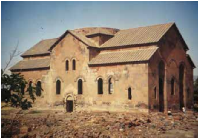
Figura 1. La chiesa di Arudj, Armenia. Si nota che il crollo della cupola ha garantito la sopravvivenza della struttura, nonché le nicchie 'scavate' onde alleggerirla
