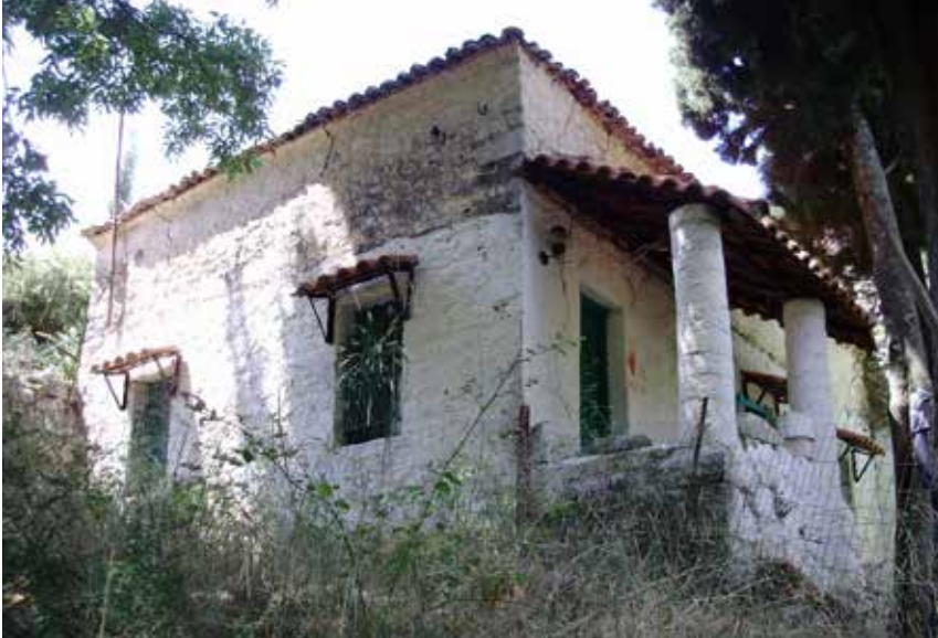
Figura 2. La tekke di Xhermahalle, Albania (foto: Gruppo di lavoro del Dipartimento di Architettura e studi urbani del Politecnico di Milano, per gentile concessione)
