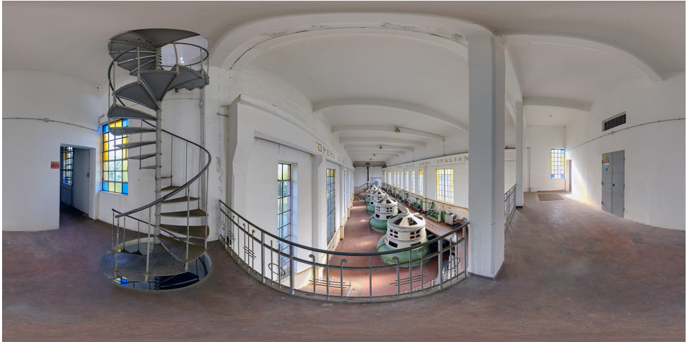
Figure 12 Chiara Masiero Sgrinzatto, Luca Vascon, Terme Water Pumping Plant, Interior . 2009. Digital 360° photograph / 10500×5250 px. Caorle (VE), Consorzio di Bonifica del Veneto Orientale. © Chiara Masiero Sgrinzatto; Luca Vascon
